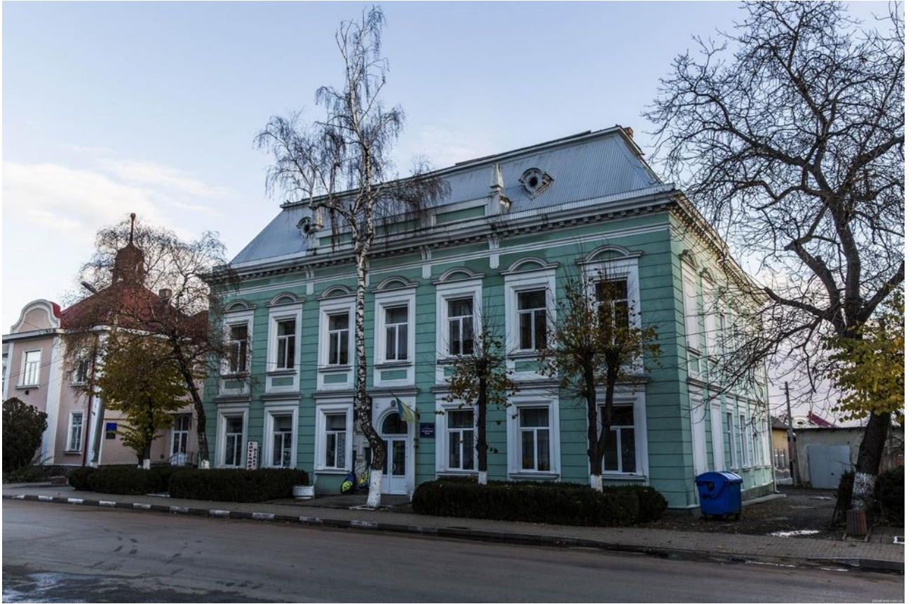
Рис.2.2. Фасад Снятинської центральної районної лікарні
