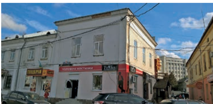
ZACHOWANE SKRZYDŁO KLASZTORU. IWANO-FRANKIWSK, UL. STAROZAMKOWA, 2
