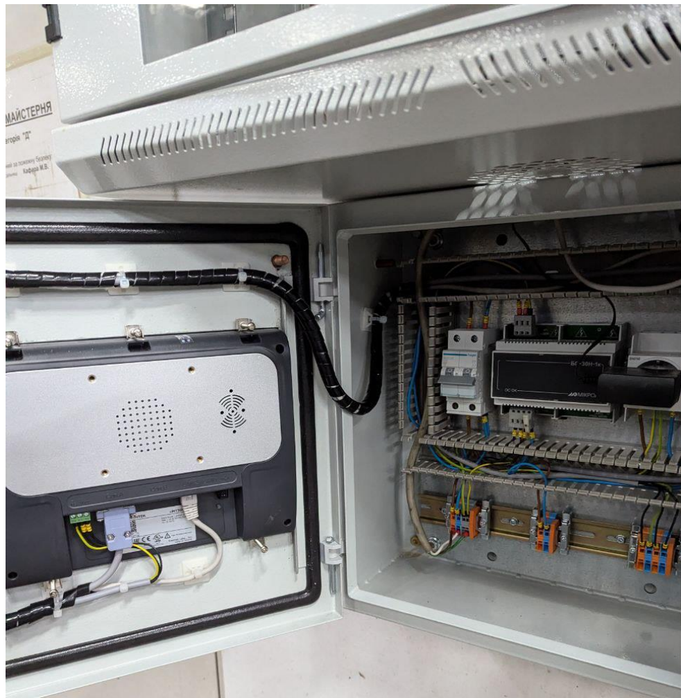
Рисунок 3.20 – внутрішня структура щита з панеллю оператора
