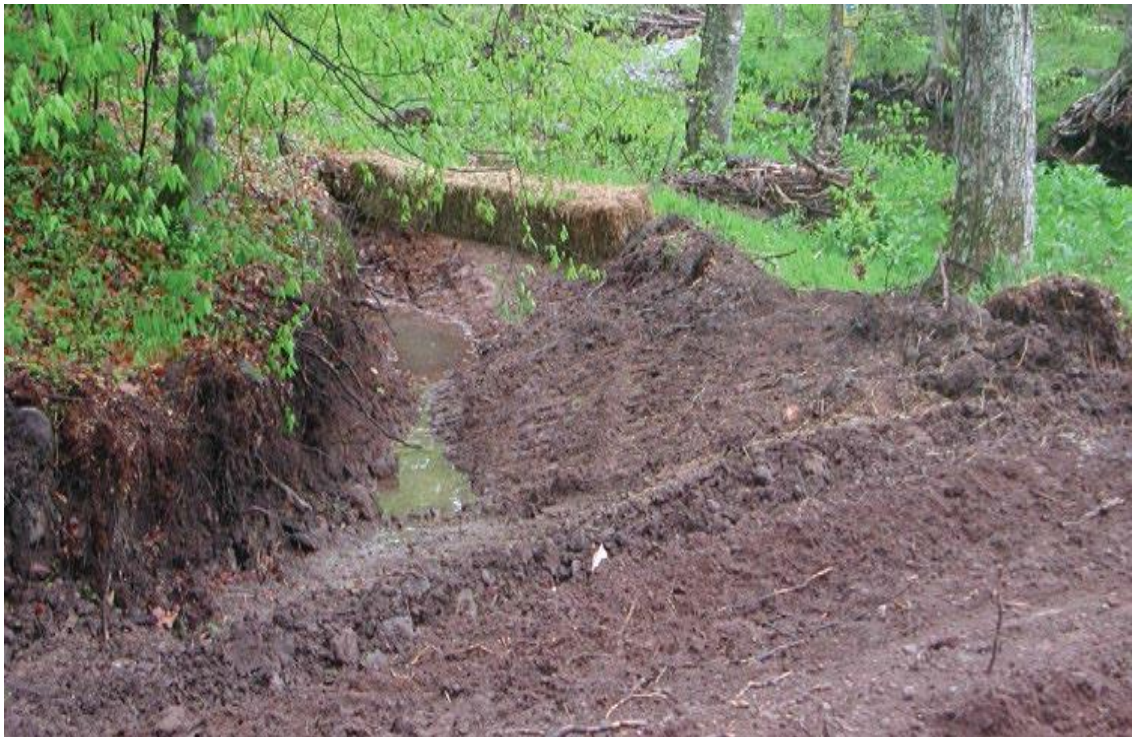
Рисунок 1.2 – Влаштування бар'єру для запобігання переміщення осаду
