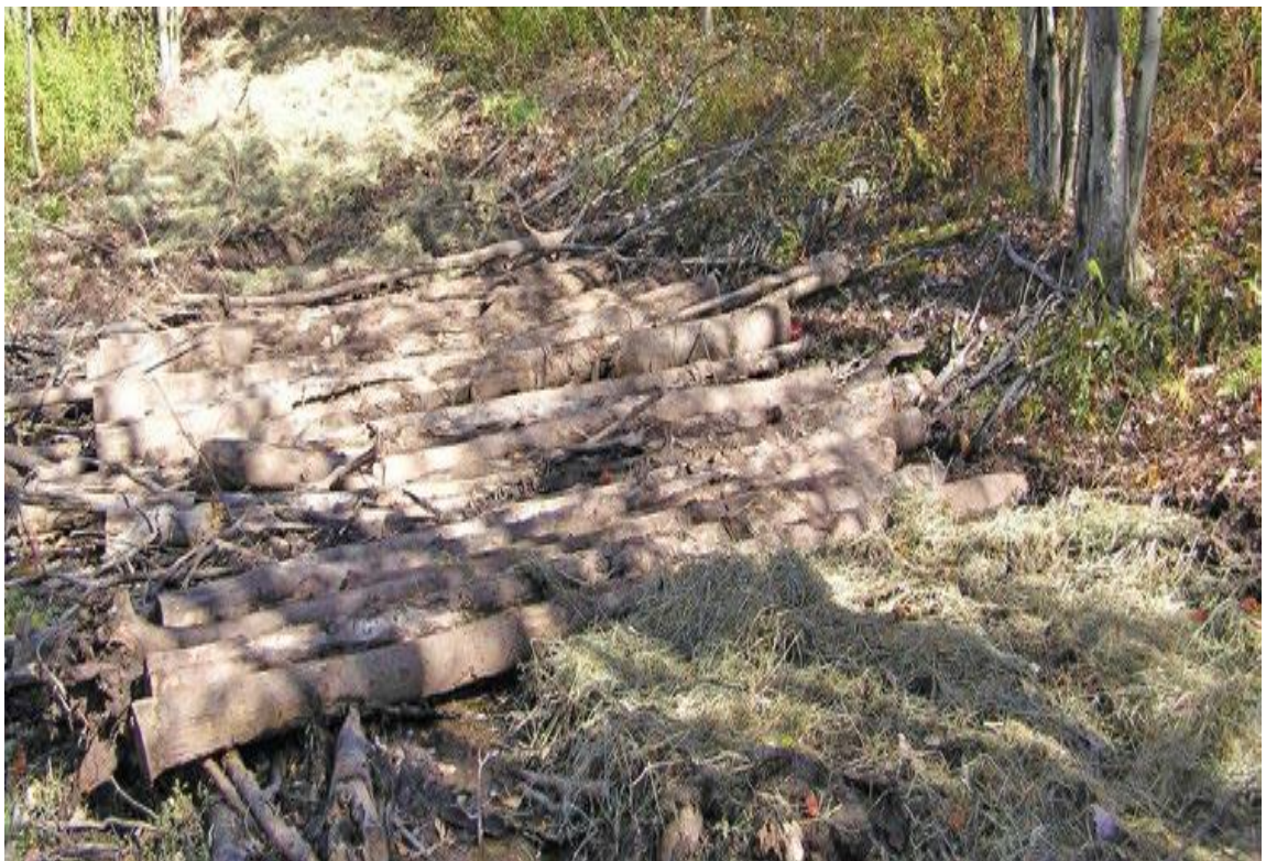
Рисунок 1.1 – Укріплення трелювального волоку низькоякісною деревиною
