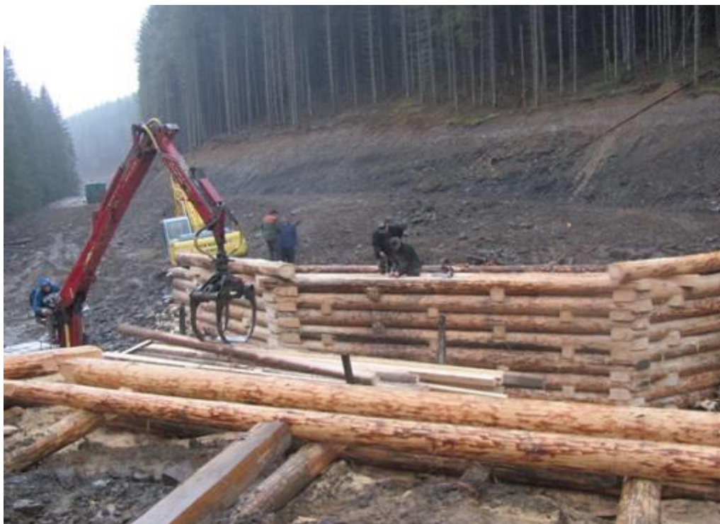
Рис.7. Берегоукріплення ріки Лімниця
